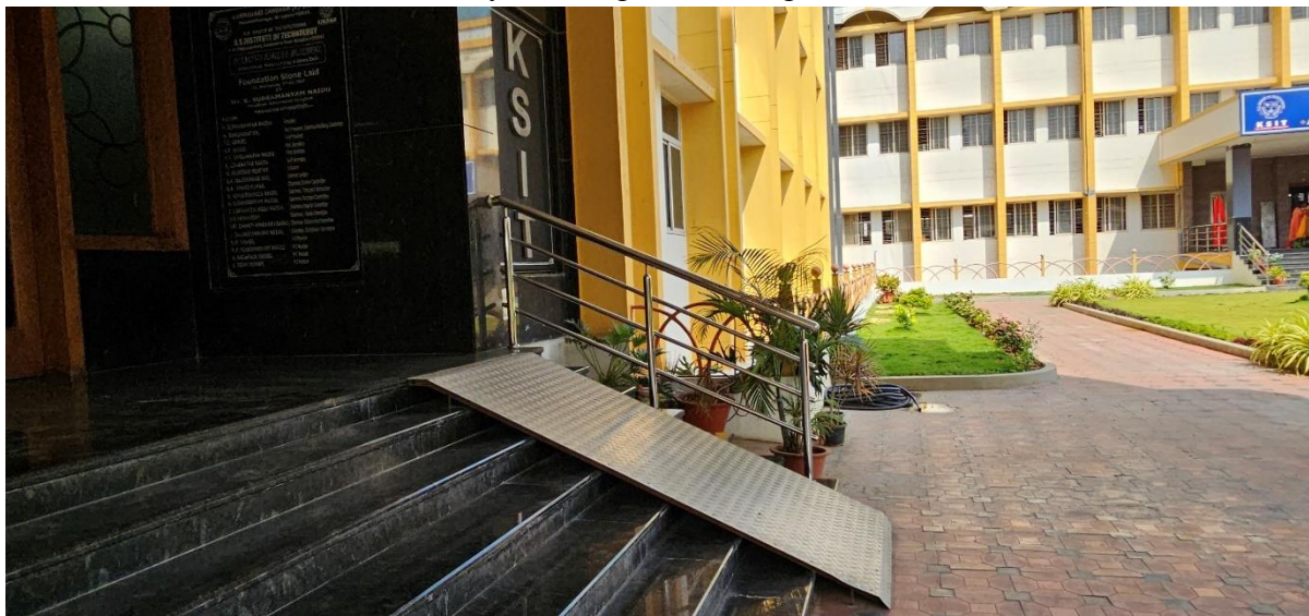
Non slippery ramps
